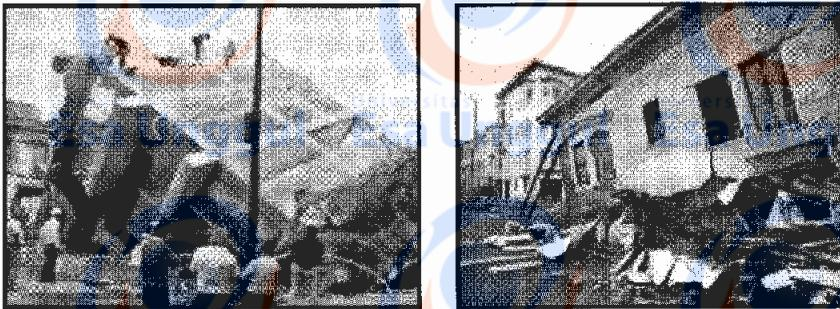
**Gambar 4.17** Dampak dari getaran gempa (Ground shaking yang menyebabkan runtuhnya bangunan. Tampak dalam gambar bangunan di Mexico city yang diakibatkan oleh gempa bumi tahun 1985.
